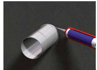
Fugning rundt om gennemføringer
